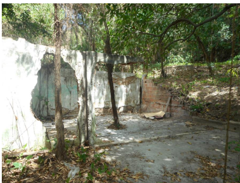
TBF – Estrutura de cimento (Foto: Projeto Campos e Saberes)
