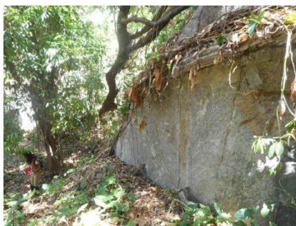
Acesso ao fundo e à esquerda; e vestígio de telhado de amianto cravado no afloramento rochoso (Foto: Projeto Campos e Saberes)
