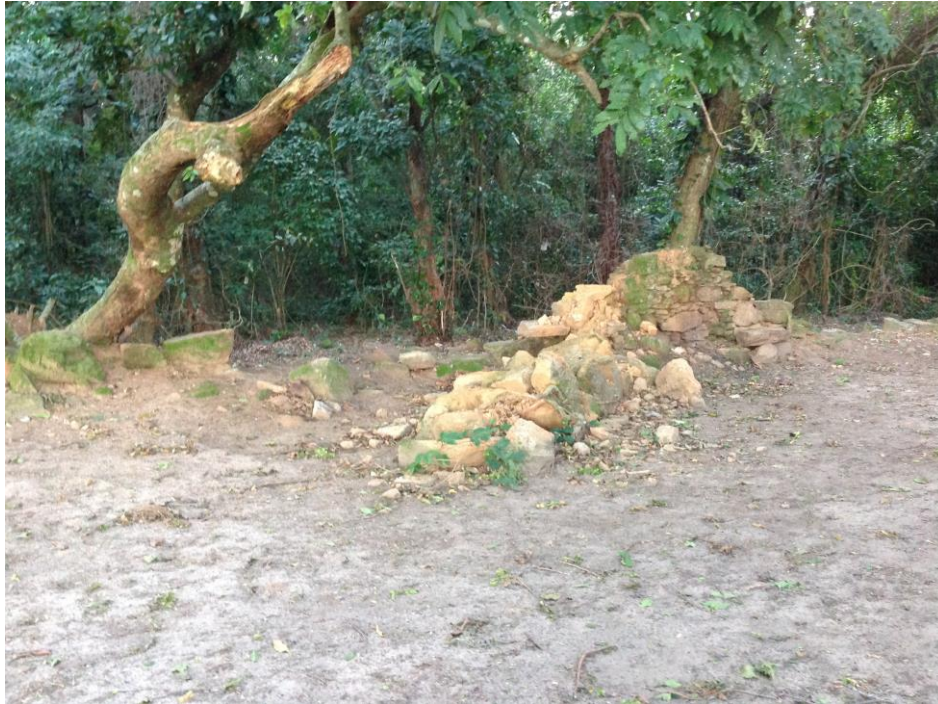
Exemplo de coluna desmoronada em CML1 recentemente (coloração avermelhada da argamassa exposta)
