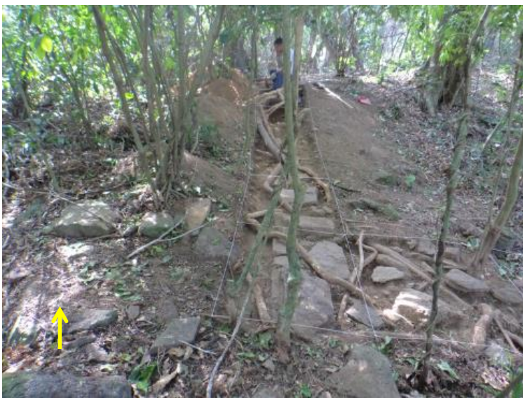
Muro evidenciado em elevação abrupta do terreno (CML2 / T1) (seta amarela indica o Norte)
