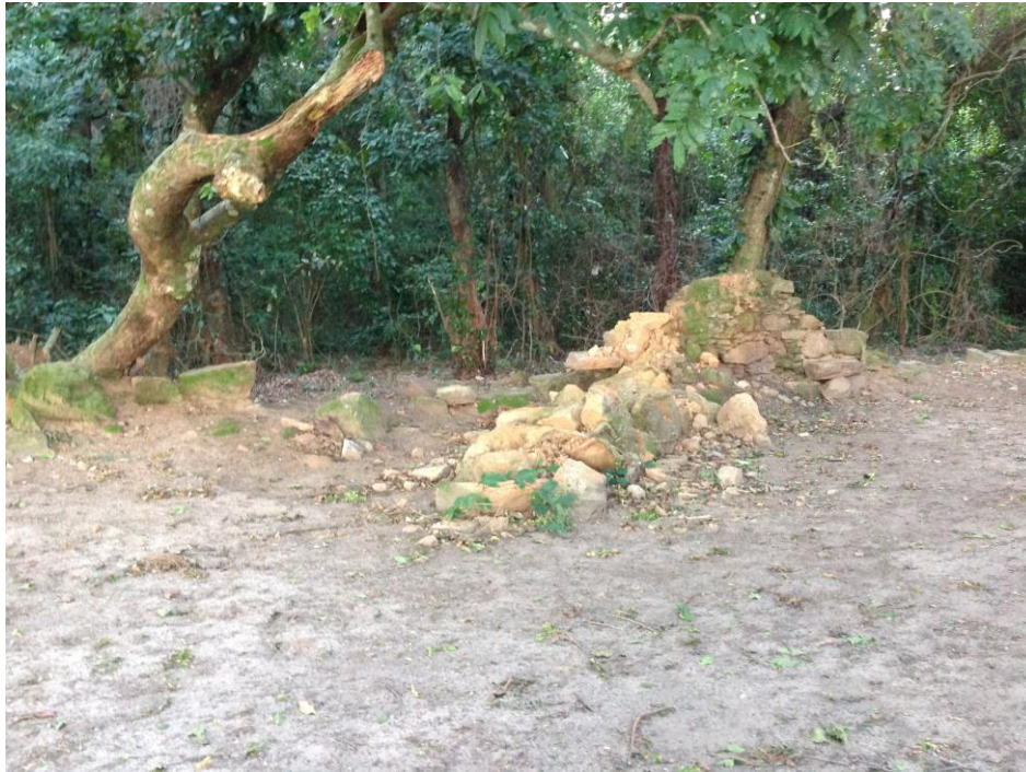
Exemplo de coluna desmoronada recentemente (coloração avermelhada da argamassa exposta)
