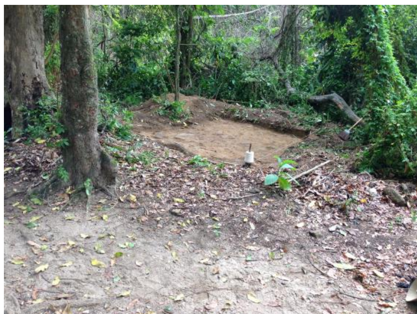
Localização do calçamento exposto com relação à Estrada e ao caminho utilizado atualmente por pedestres
