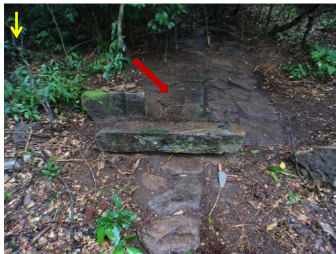
Alinhamento da parede com soleira (seta vermelha) e calçamento em rampa (seta amarela indica o Norte)
