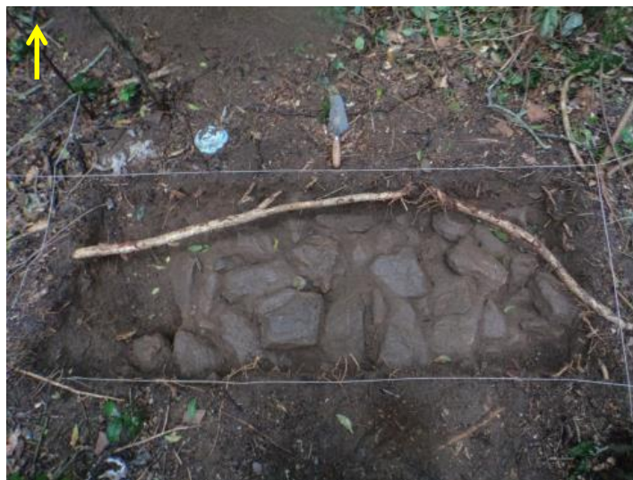
Muro evidenciado na elevação abrupta do terreno (CML2 / T2) (seta amarela indica o Norte)
